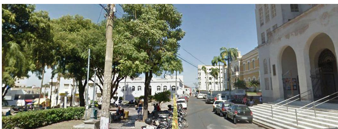
Figura 9 - Vista do Museu Histórico de Mato Grosso e entorno. Museu (no centro ao fundo antes da pintura de 2015), avizinhado pelo Correio Central (a esquerda), destaque para Praça da República (na frente), Catedral (direita), avizinhada pelo Palácio da Instrução. Fonte: Google Earth Pro.
