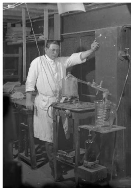
Figura 16. Fotografia do Alambique para água destilada. 30/10/1926.
