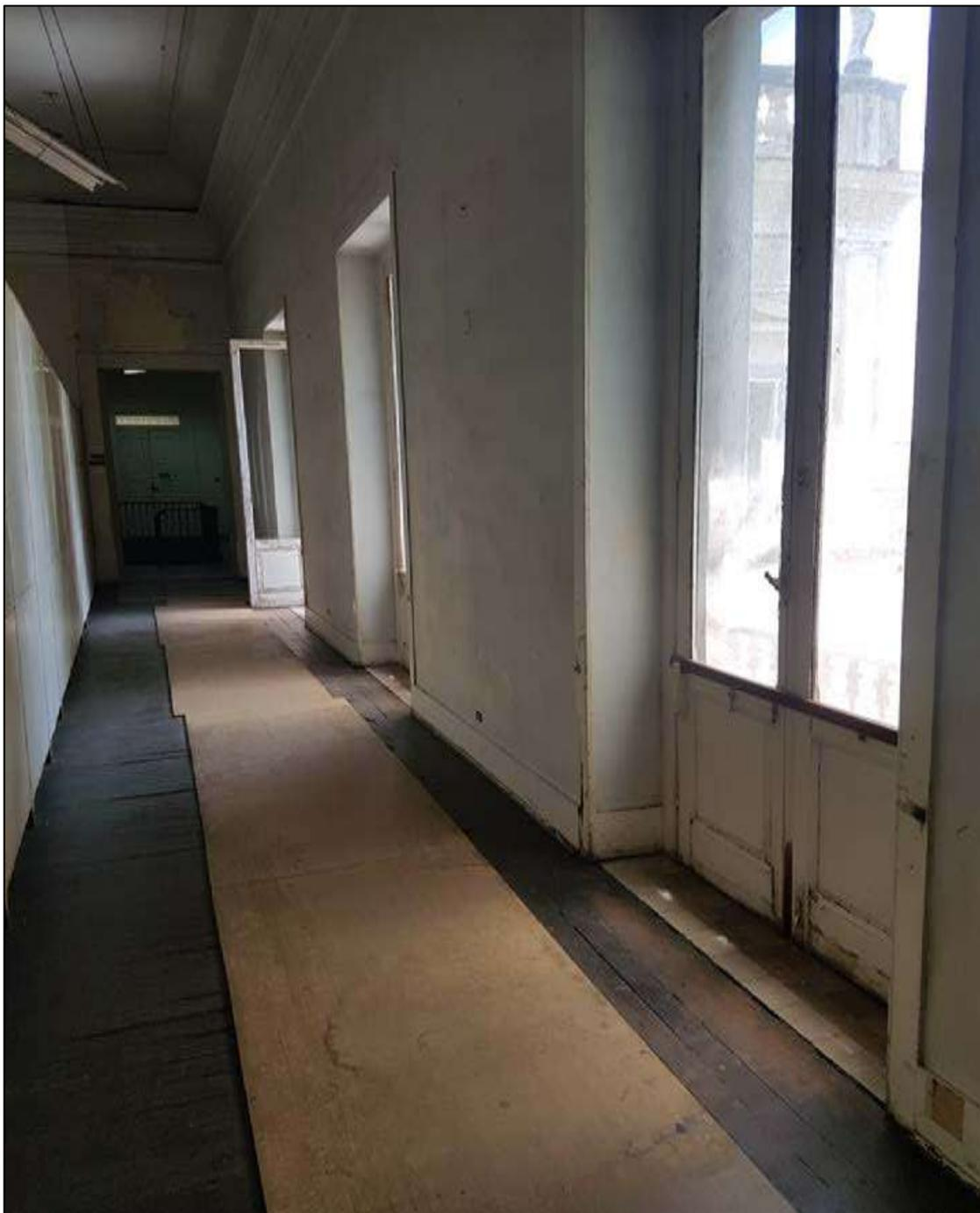
Imagem 115: Foto do corredor entre a Reserva Técnica de Etnografia e as sacadas. As tábuas ali colocadas sobre piso que cedeu por necessidade de manutenção e infestação de pragas.
