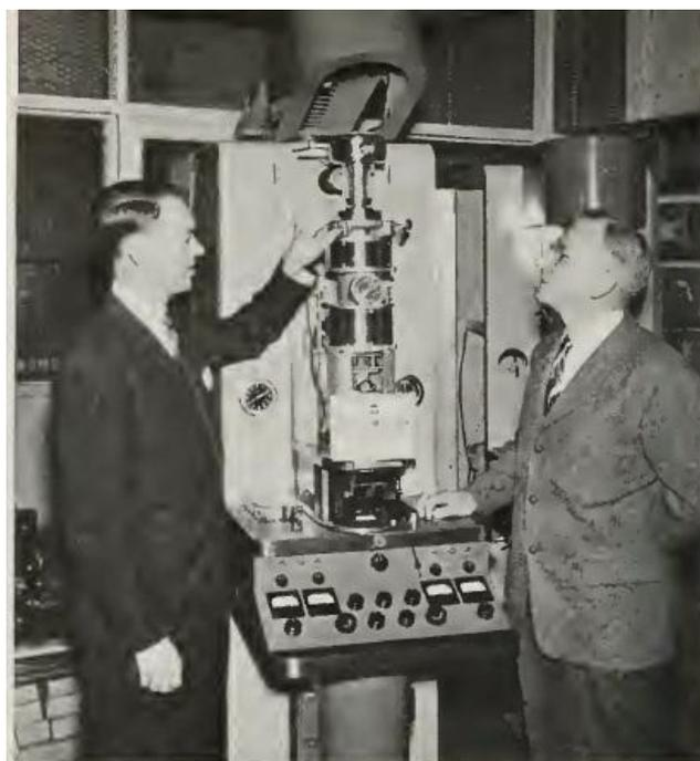
**Figura 16** – T. A. Smith, do departamento de produtos da RCA Victor Engineering, explica os detalhes do 200º microscópio eletrônico ao Dr. P. E. Klopsteg, da *Northwestern University* (RADIO AGE, jan. 1947, p. 26).
