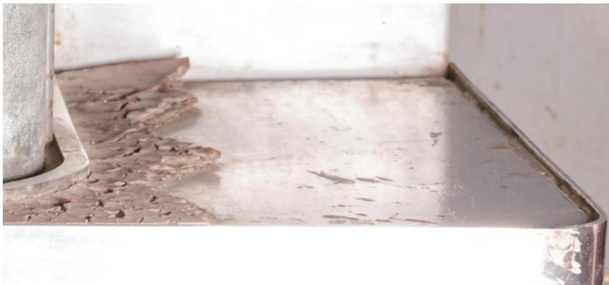
Imagens do microscópio eletrônico RCA EMU-2C no depósito do Pavilhão Lauro Travassos (à esquerda) e na reserva técnica museológica do Museu da Vida (à direita e abaixo), evidenciando área de perda de peças e de parte do revestimento superior do painel de comandos. O revestimento restante está bastante craquelado e possivelmente esse craquelamento favoreceu o destacamento do revestimento.
