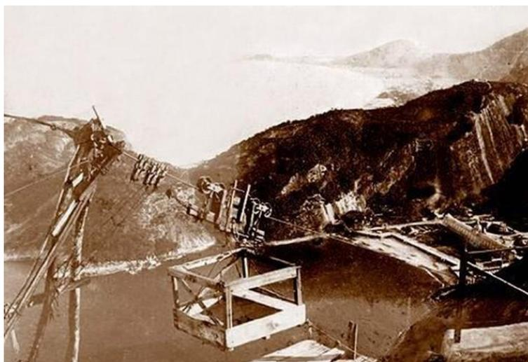
Figura 31. Transporte de carga, construído para levar os equipamentos e operários para o alto do morro da Urca no início das construções. FONTE: Acervo CCAPA.
