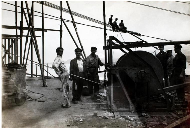
Figura 34. Montagem do maquinário do teleférico no morro da Urca. Vê-se em primeiro plano, o guincho manual
