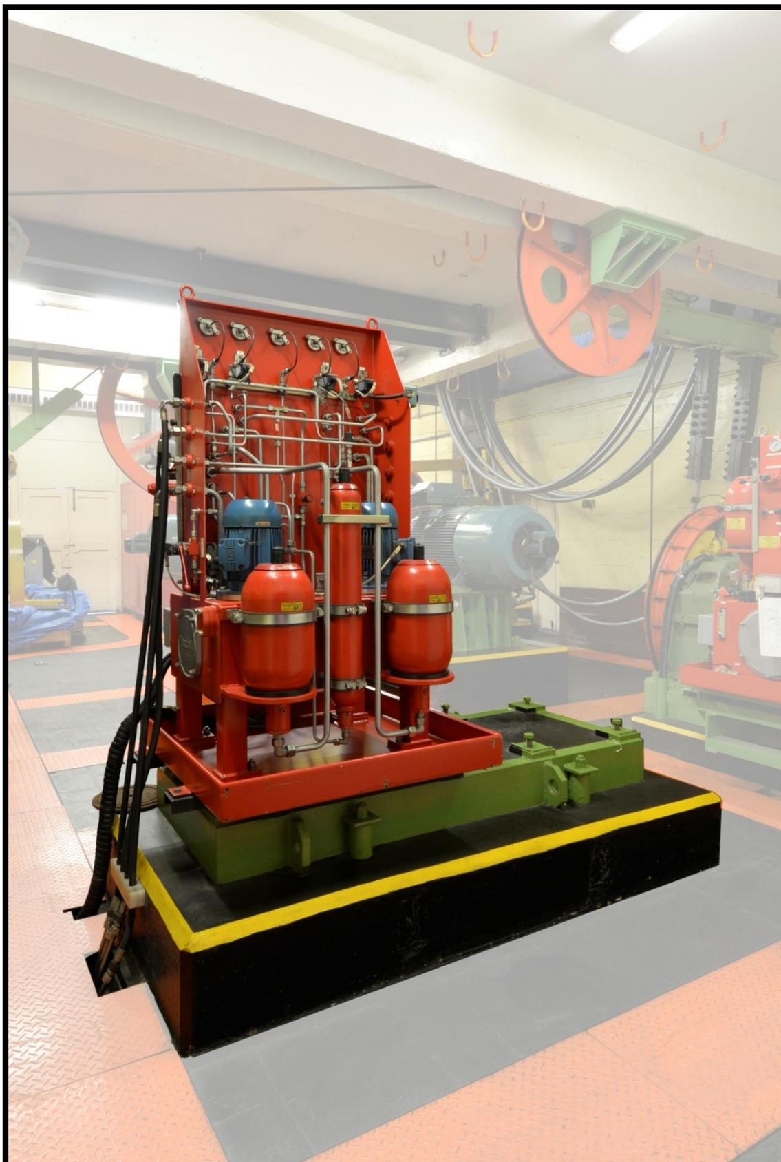
Figura 59. Central hidráulica de comando dos freios da estação motriz do teleférico da 3ª geração, fabricada pela empresa Agudio, Itália. A sua função é liberar o óleo para erguer o freio de serviço, liberando a polia motriz para movimentar o teleférico. Atualmente está em funcionamento e fica localizado na Casa de Máquinas da Estação III, Morro da Urca. Foto Paulinho Muniz. Número de registro: 2000163. FONTE: Acervo CCAPA.
