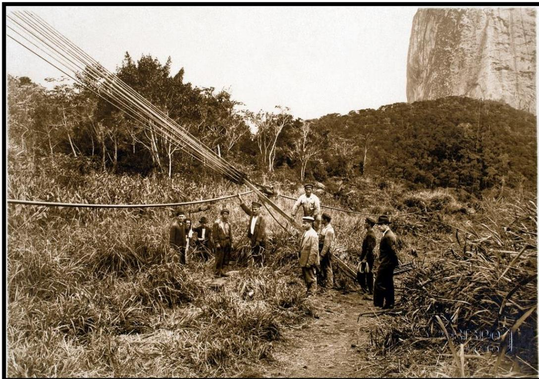
Figura 16. Foto Alonso Bispo. Operários estirando cabos para instalação da segunda linha: Morro da Urca/Pão de Açúcar. FONTE: Acervo CCAPA, 1912.
