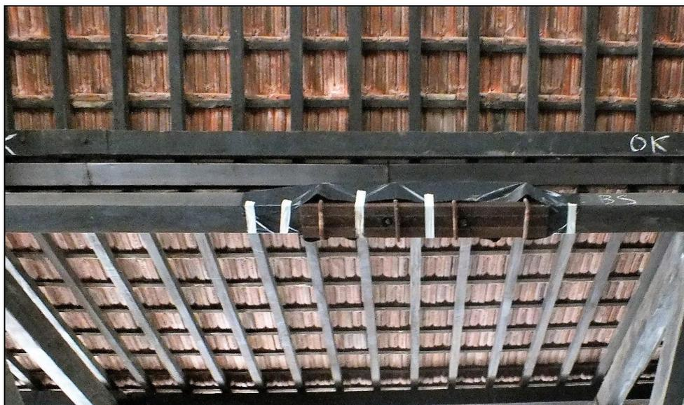
Figura 12 - Detalhe da correção do madeiramento que se encontra sob uma das emendas da calha.
