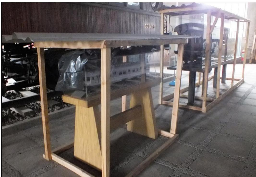
Figura 40 - Proteção temporária para os expositores de vidro durante a intervenção no telhado. As estruturas minimizam o risco de danos.
