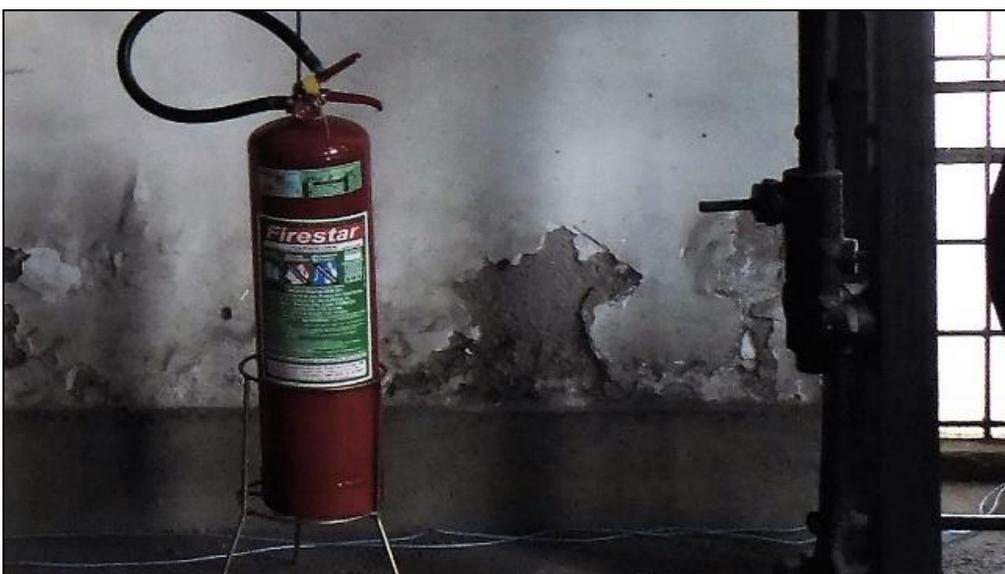
Figura 8 - Detalhe de patologia da argamassa.
