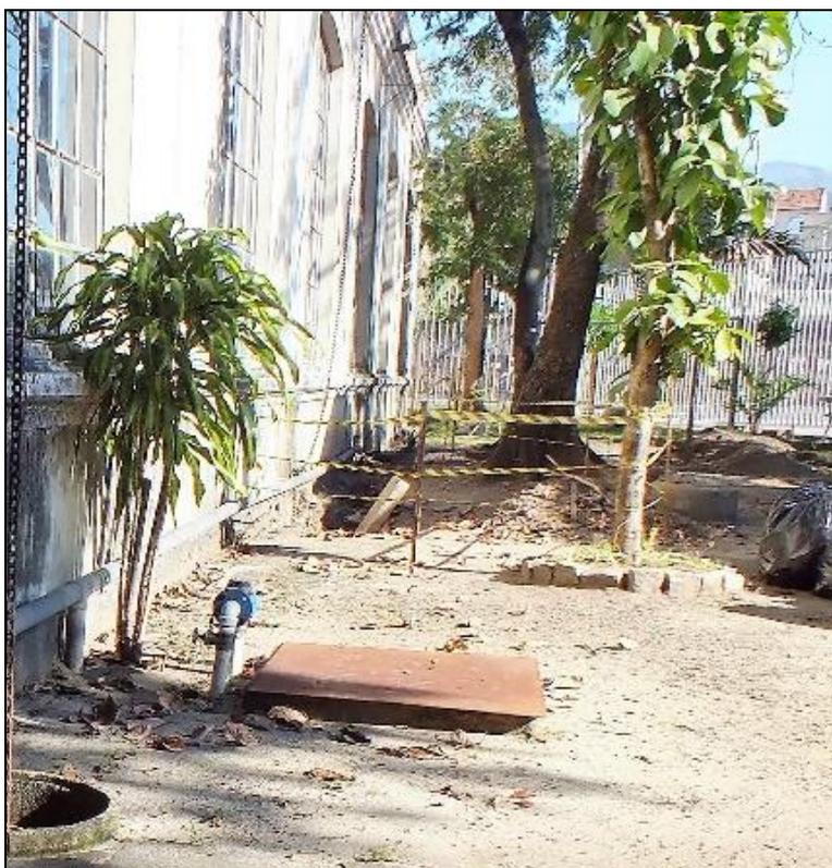
Figura 11 - Abordagem do problema de infiltração durante o serviço de conservação.
