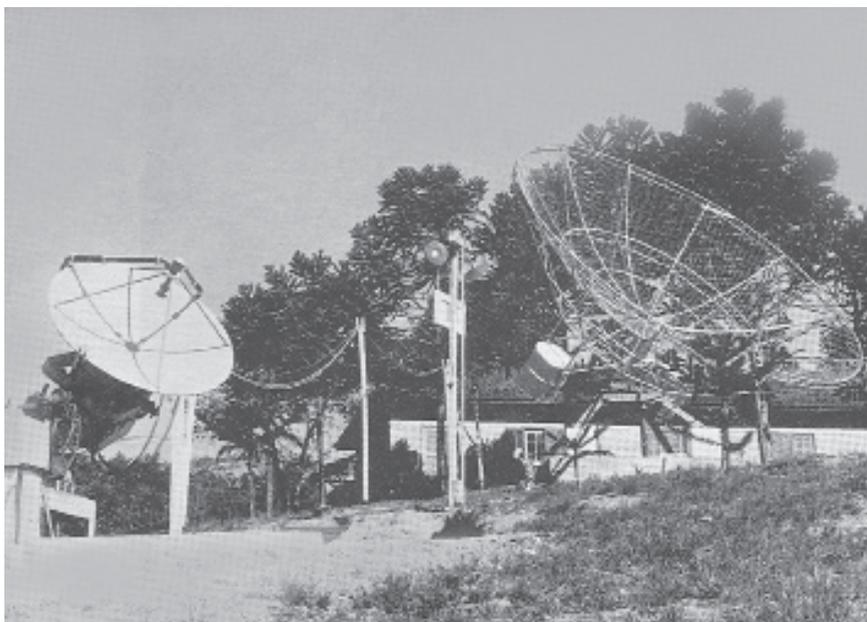
**Figura 3.** O Rádio Observatório do Umuarama em Campos do Jordão, SP, vendo-se da esquerda para a direita a antena de 1,5 m do radiopolarímetro em 7 GHz e a antena de 5,2 m do receptor em 300 MHz (Kaufmann, 1968)
