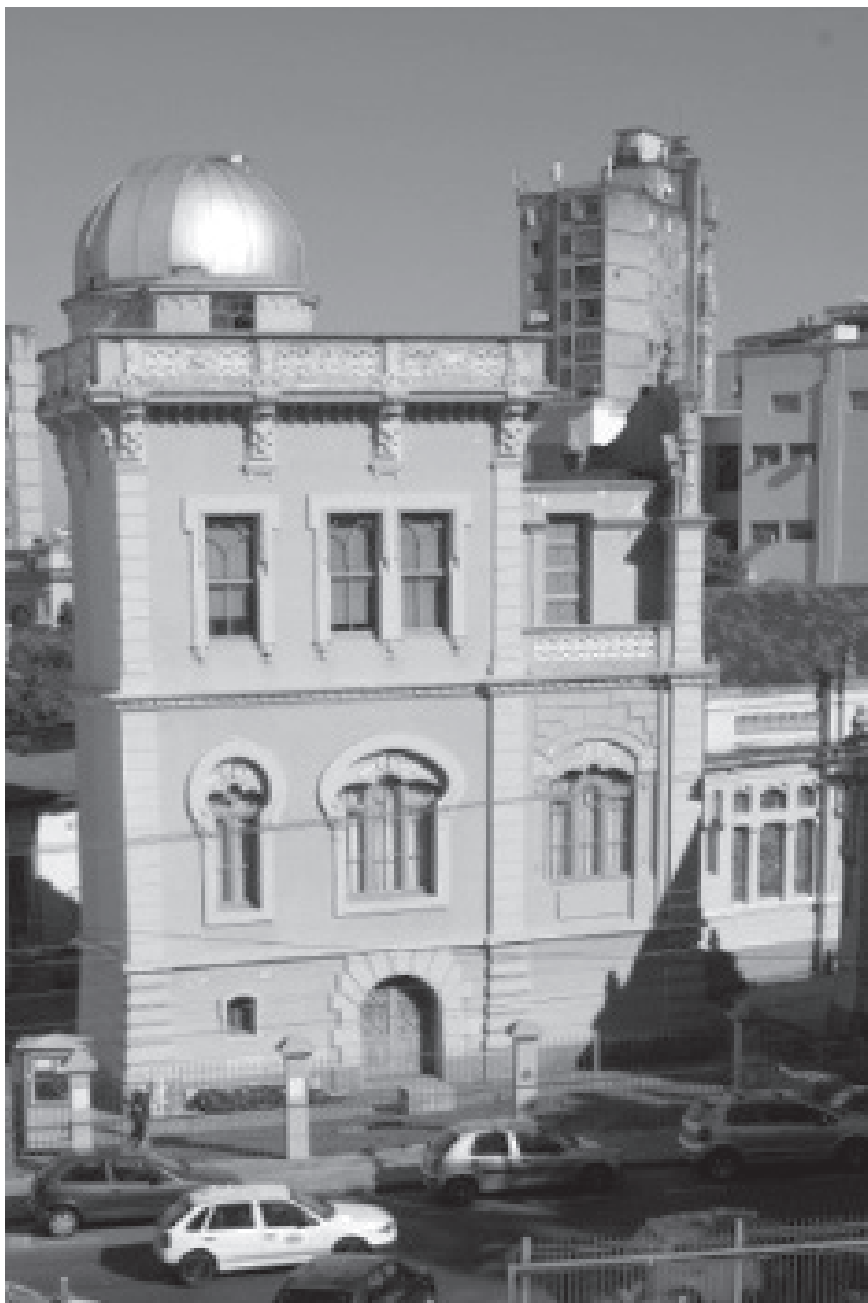
Figura 6. Vista atual da fachada Norte. Foto do Autor
