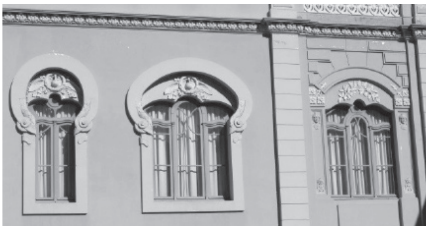
Figura 9. Vista em detalhe das janelas do segundo pavimento na fachada Norte. Foto do autor
