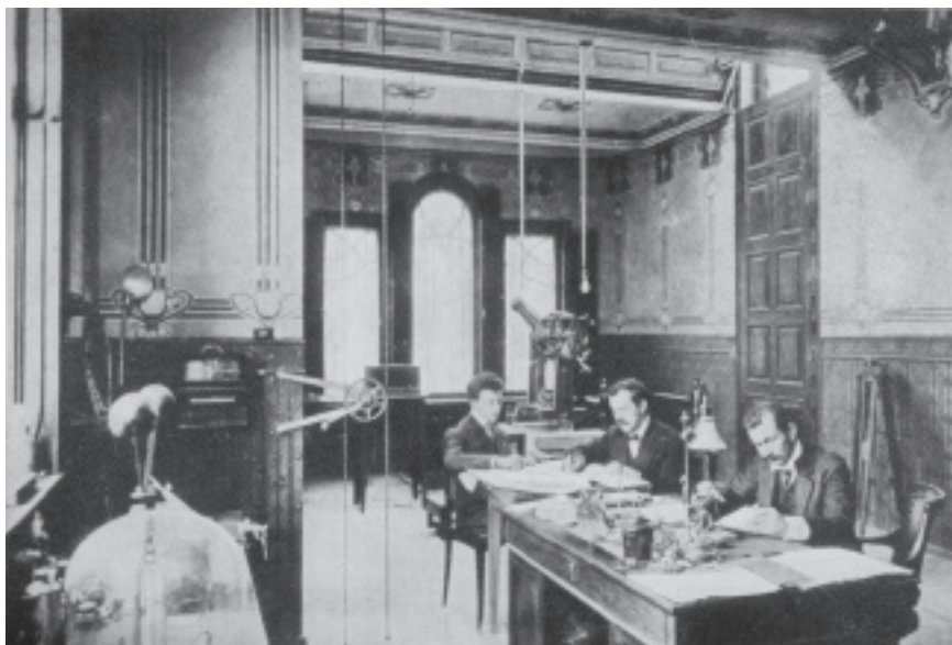
Figura 4. Aspecto da sala meridiana em 1910. Em primeiro plano o engenheiro Itaquy e seus auxiliares. A esquerda, a engrenagem que movimentava a trapeira da luneta meridiana que se visualiza aberta sobre esta. Acervo do OA/UFRGS
