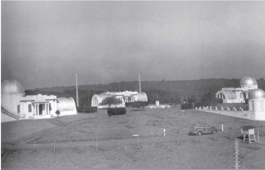
Figura 11. Conjunto arquitetônico do Observatório Astronômico de São Paulo no Parque do Estado. Da esquerda para direita: o Pavilhão Cooke, que abriga o telescópio Zeiss de 175 mm; o Pavilhão do Serviço Meridiano e o Pavilhão Fotográfico que abrigava o telescópio Grubb de 200 mm (Acervo IAG)
