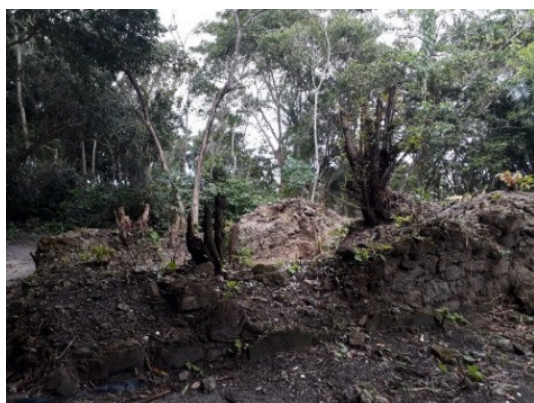
Figura 6 – Nave- Lateral direita: Estrutura murária em pedras aparelhadas com perda acentuada.
