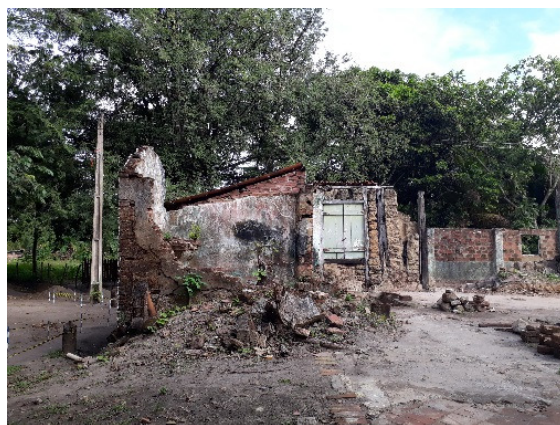
Figura 5 – Evidenciação de piso com intervenção recente.
