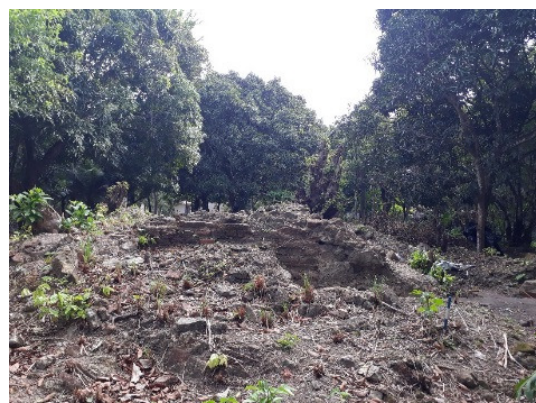
Figura 7 – Altar: Perda acentuada de alvenaria.
