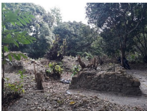
Figura 8 – Sacristia: Parte da estrutura murária com pedras aparelhadas e perdas.
