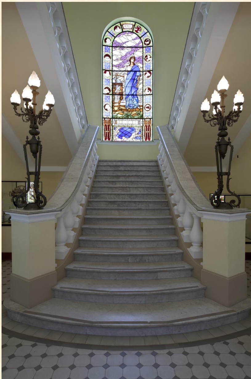
Escadaria em mármore de Carrara, ornamentada por duas luminárias de metal dourado, com 06 globos de vidro branco acetinado cada uma, imitando labaredas, hall do Edifício Sede do MAST (Foto: Jaime Acioli, 2010).
