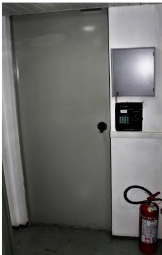
Figura 3 - Porta de entrada da reserva técnica com controle biométrico. Note-se também a presença do extintor de incêndio - LEEEH-USP. Foto: Rodrigo E. Oliveira, 2017
