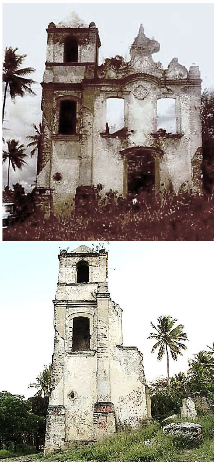
Figura 1 - Fachada frontal da igreja em 1978 (esquerda) e em 2015 (direita): note-se a deterioração e desmoronamento da área do frontão e janelas frontais, bem como da porta principal da entrada, com perda de cantarias (Fotos: ref. Medeiros, 2005, p. 81 e Maria Aparecida, novembro de 2015).
