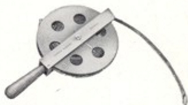
Trena de aço com graduação com furo e relêvo
